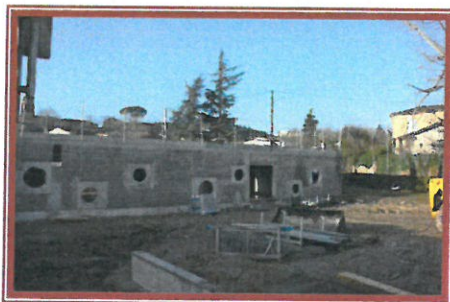
Le bâtiment coté nord
