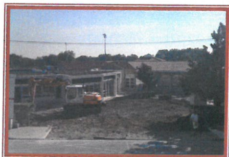
Réfection du revêtement de la cour
