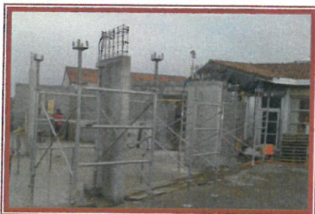
Les murs de la bibliothèque montent
