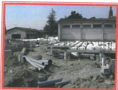
2003 : Le chantier commence
