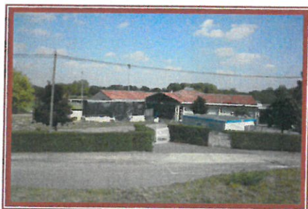
L'ancienne école élémentaire est rasée
