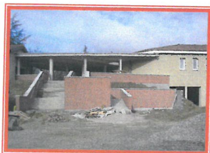
La fin des travaux
