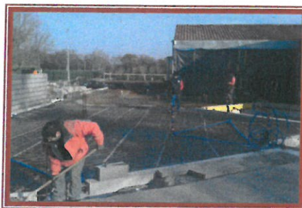
La dalle de l'école élémentaire est coulée
