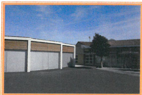
La jonction des 2 bâtiments
